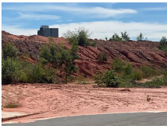
Imagens de loteamento próximo à Via Expressa de Contagem, de onde terra é carregada para bueiros de drenagem pluvial, que escoam para a calha do Córrego Sarandi
