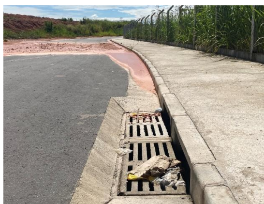
Imagens de loteamento próximo à Via Expressa de Contagem, de onde terra é carregada para bueiros de drenagem pluvial, que escoam para a calha do Córrego Sarandi
